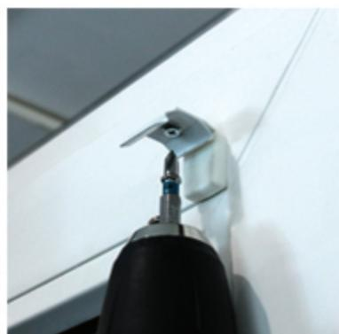
С помощью винта закрепите в стеновом кронштейне - потолочный кронштейн слева и справа.
