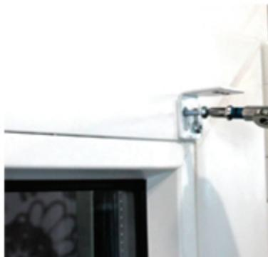
Приложите стеновой кронштейн сверху к месту замера по ширине. С помощью саморезов установите кронштейны слева и справа.
