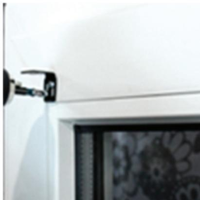
Приложите стеновой кронштейн сверху и снизу к месту замера по ширине. С помощью саморезов установите кронштейны слева и справа.
