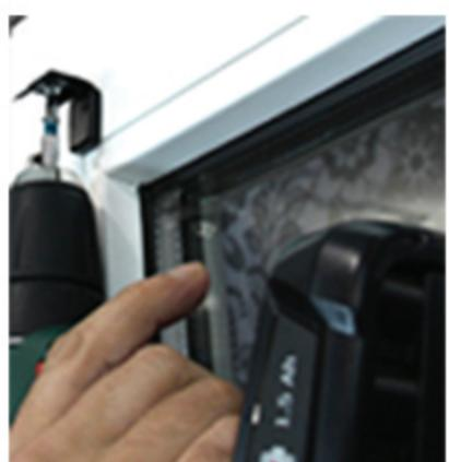
С помощью винта закрепите в стеновом кронштейне - потолочный кронштейн (2 шт сверху и 2 шт снизу).
