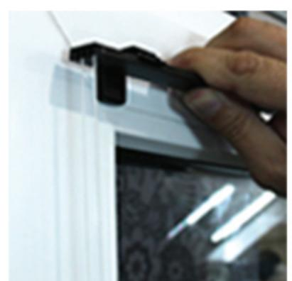
Закрепите неподвижный профиль или фиксирующую планку в потолочном кронштейне сверху и снизу.
