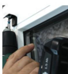
С помощью винта закрепите в стеновом кронштейне - потолочный кронштейн.
