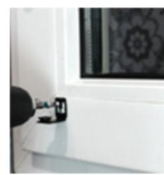
Приложите стеновой кронштейн с защелкой для башмачка снизу к месту замера по ширине. С помощью саморезов установите кронштейны слева и справа.
