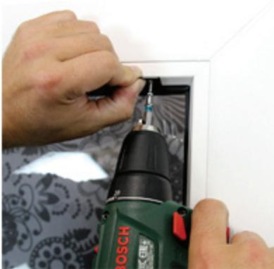
Отступить справа и слева от края штапика 3-4 см. С помощью саморезов установить на штапик кронштейн потолочный.
