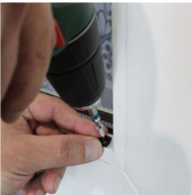
С помощью саморезов установить на край штапика справа и слева защелку кронштейна башмачка.
